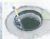
2 土砂除去作業 切断完了後、マンホール周辺の土砂を除去します。
