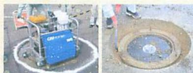
1 切断作業 GM ラウンドカッターを設置し、各々最大 15cm まで切断します。
