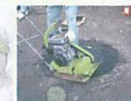
3 路盤充填作業 ラウンドベースを用いて路盤部を充填します。
